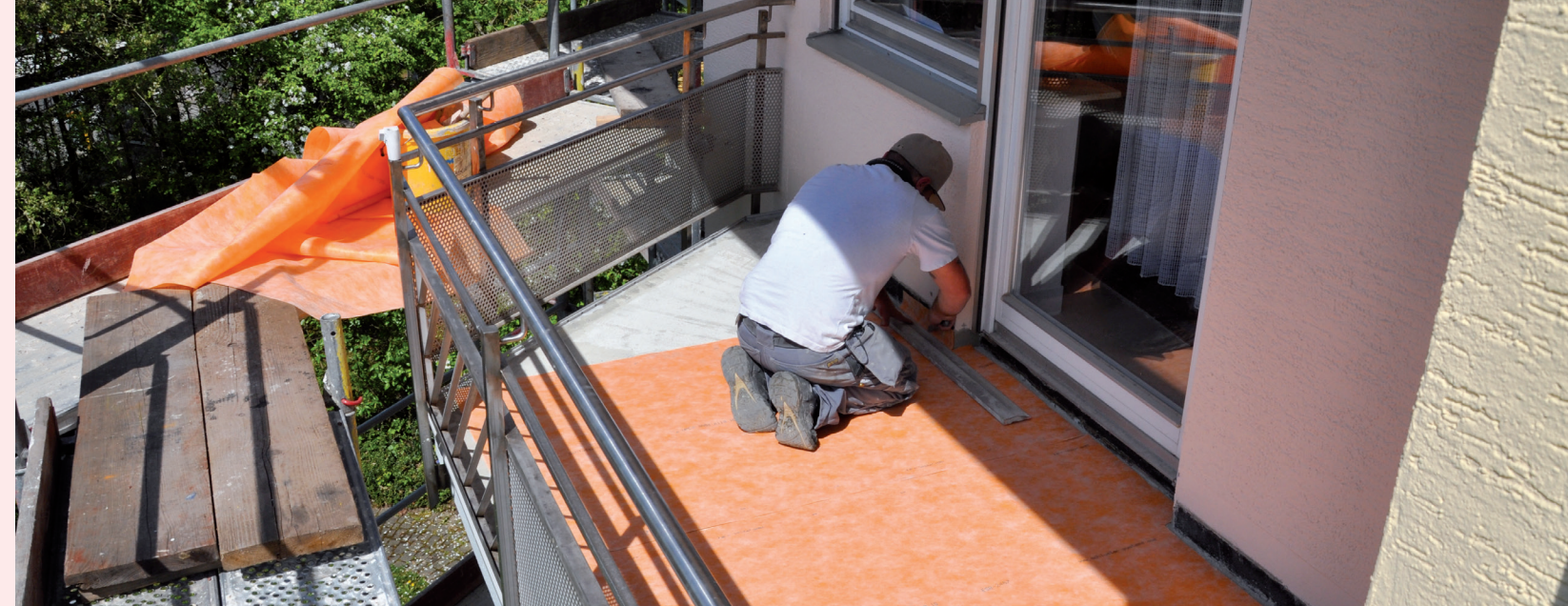
Balkon- und Fassaden-Renovierung
